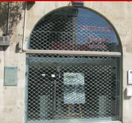
סורג גלילה מחוליות – מאפשר מבט פנימה לחנות גם כשהיא סגורה
